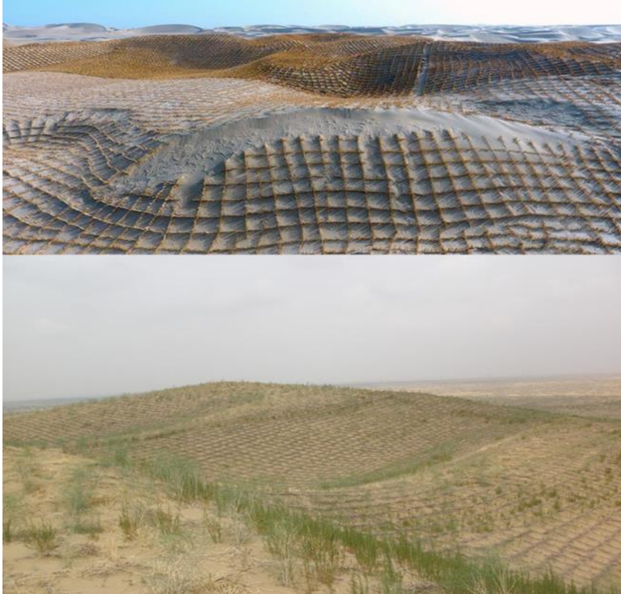
Photo N°20 : Fixation des dunes par la technique de quadrillage en Chine (Youb.o 2010).
