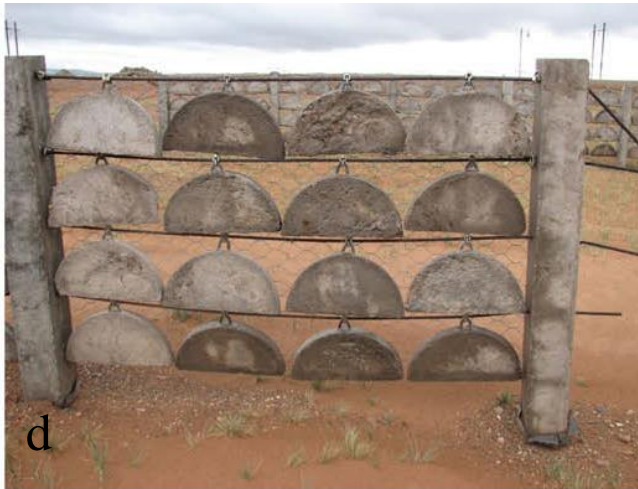
Photo N°26 : Technique de barrière de sable pour protéger la voie ferrée contre l'avancement du sable ((ZhangKecun, 2010)(ZhangKecun, 2010)(ZhangKecun, 2010)(ZhangKecun, 2010)(ZhangKecun, 2010).
