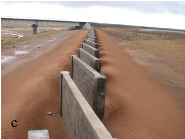
Photo N°26 : Technique de barrière de sable pour protéger la voie ferrée contre l'avancement du sable ((ZhangKecun, 2010)(ZhangKecun, 2010)(ZhangKecun, 2010)(ZhangKecun, 2010)(ZhangKecun, 2010).
