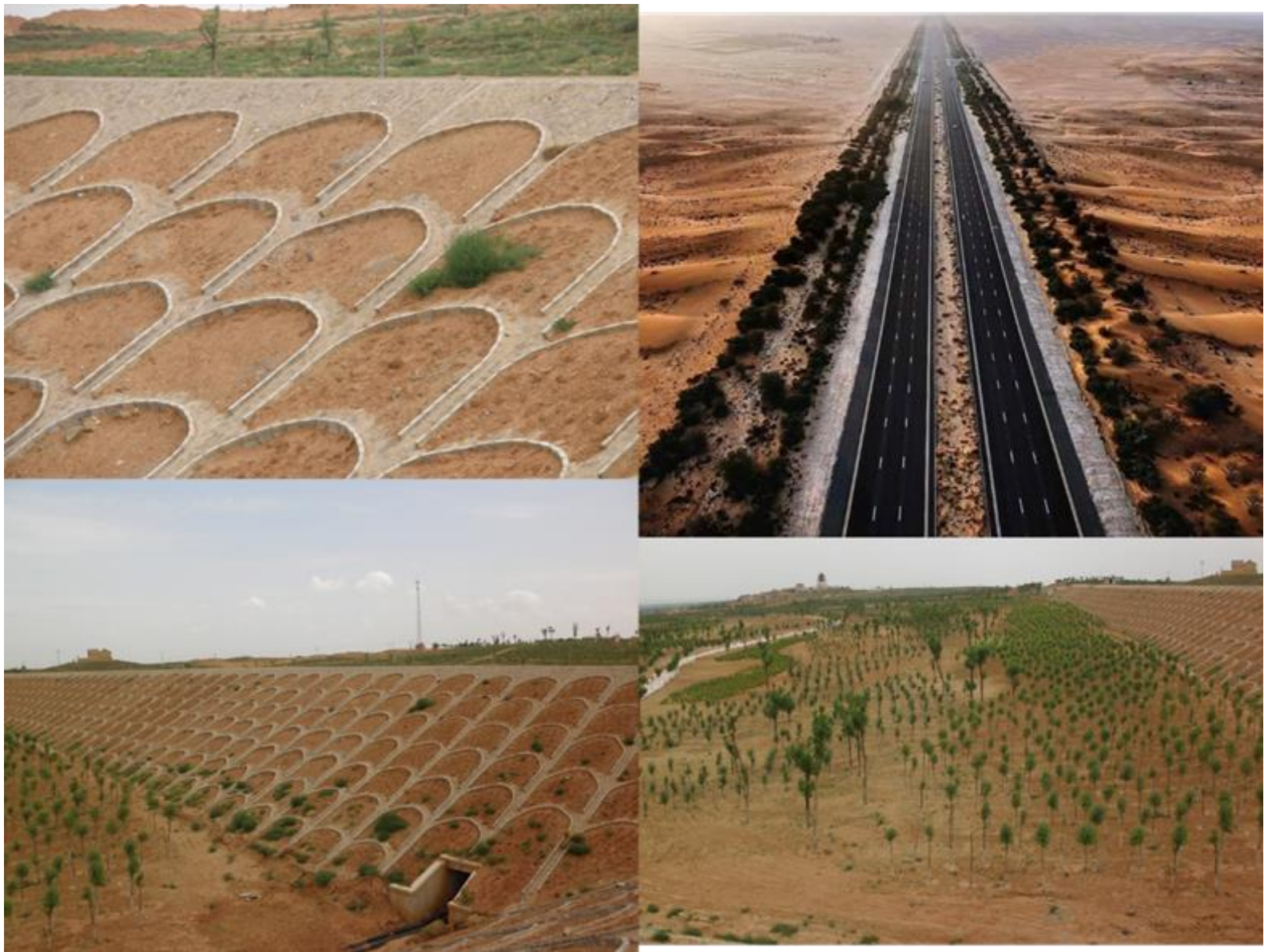
Photo N°27 : Technique chinoise de lutte contre l'ensablement des routes
